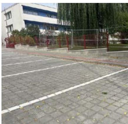
Výstavba nového parkoviště u MŠ
