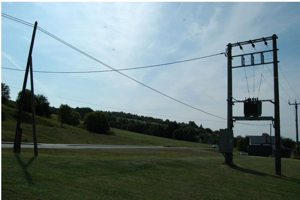
Pohled severní včetně napojného místa NN
